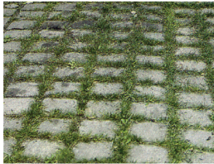
Pflaster mit offenen Fugen
